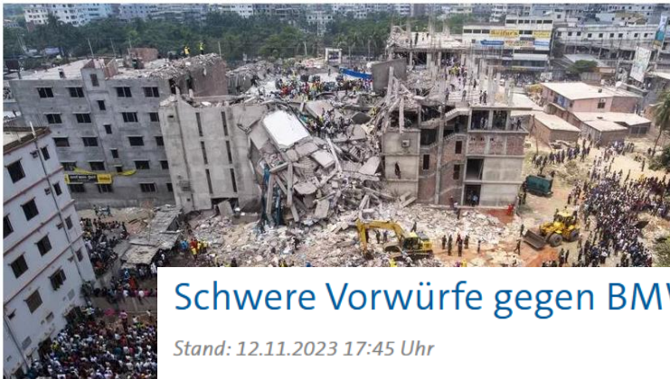
Das Fabrikgebäude Rana Plaza
